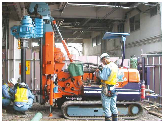
小型短尺施工機施工状況
