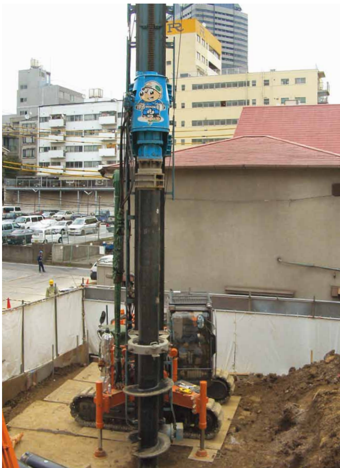
東京都内での施工状況
