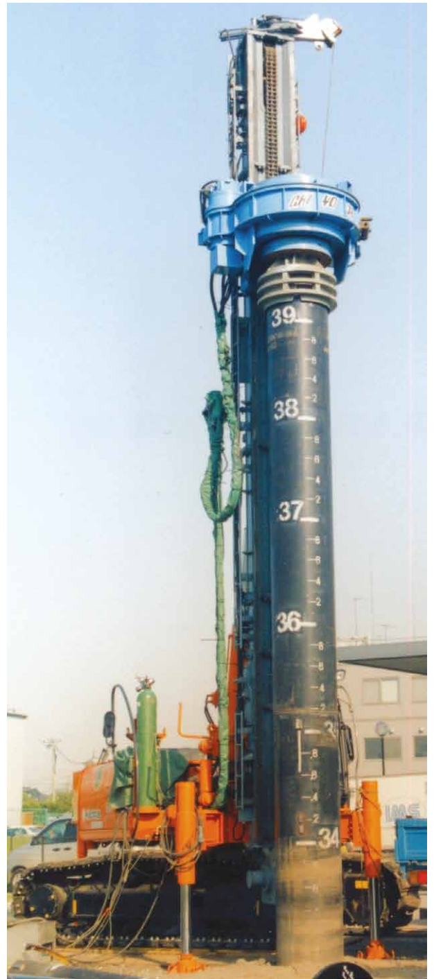
下杭φ406.4mm～上部拡頭杭φ609.6mm施工
