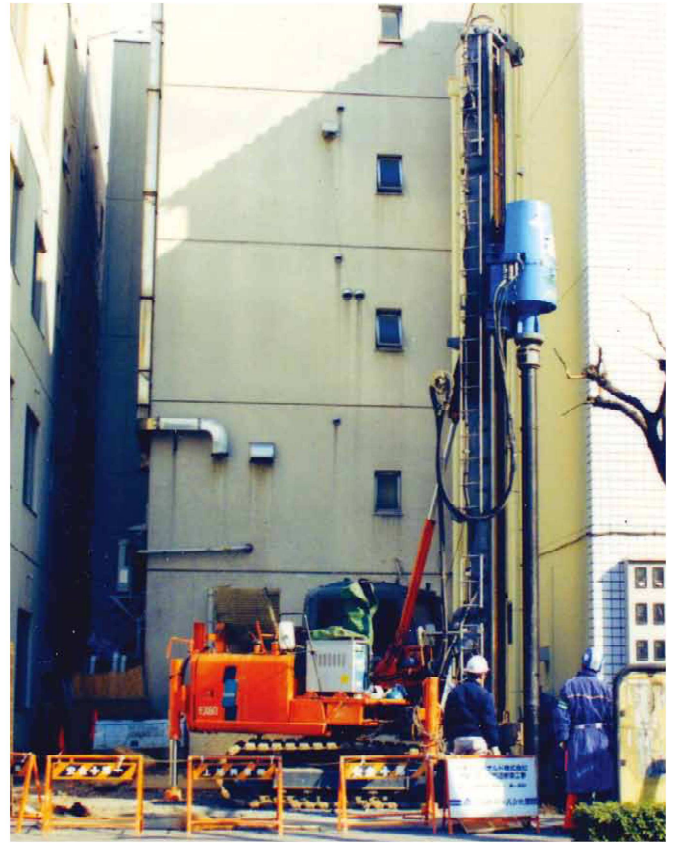
狭小敷地の施工状況
