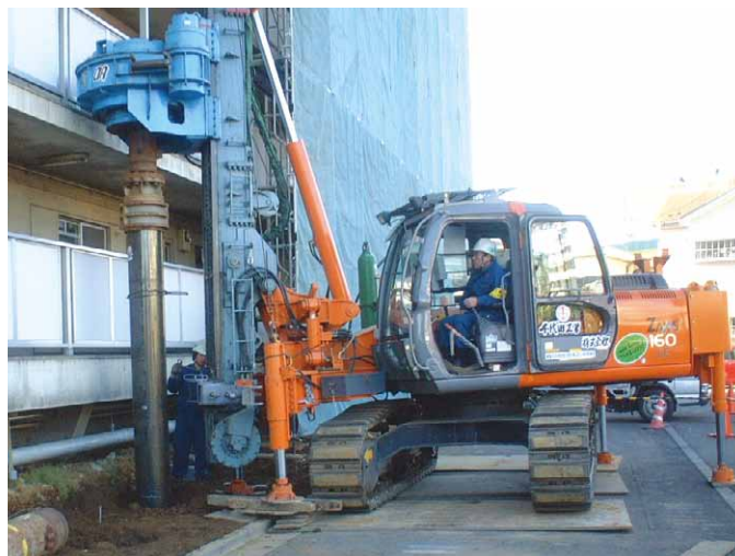
建物近接施工状況
