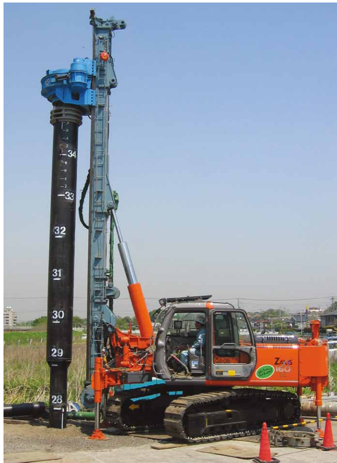
拡頭杭施工状況
