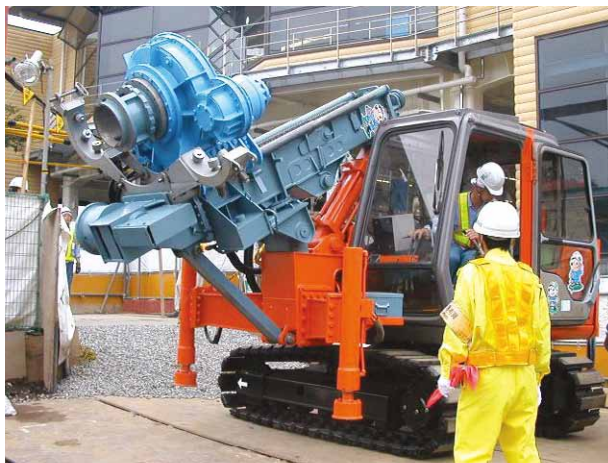
小型短尺施工機搬入状況
