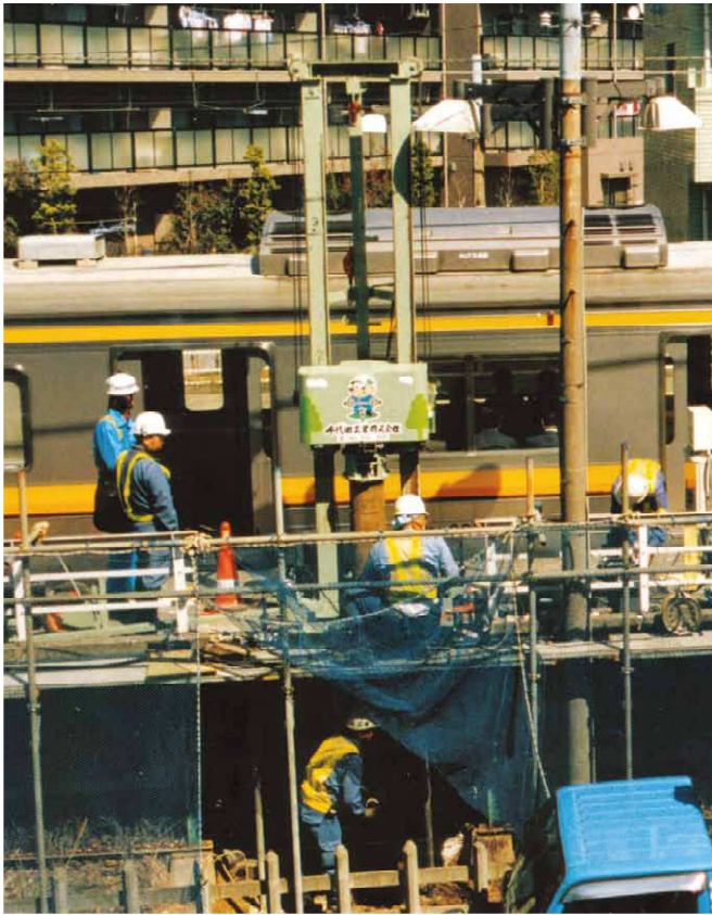
組み立て式櫓ホーム上の施工
