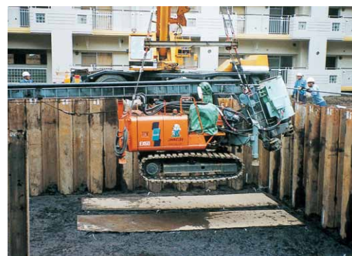
クレーン吊り搬入状況
