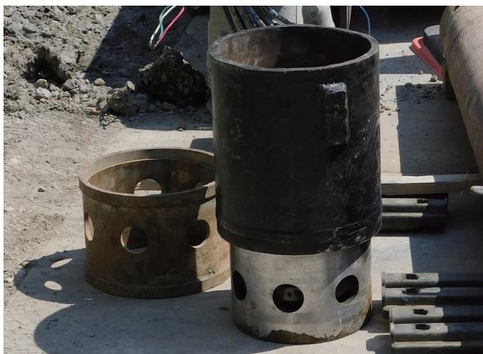
継手保護材(左)と杭頭接合管(右)
