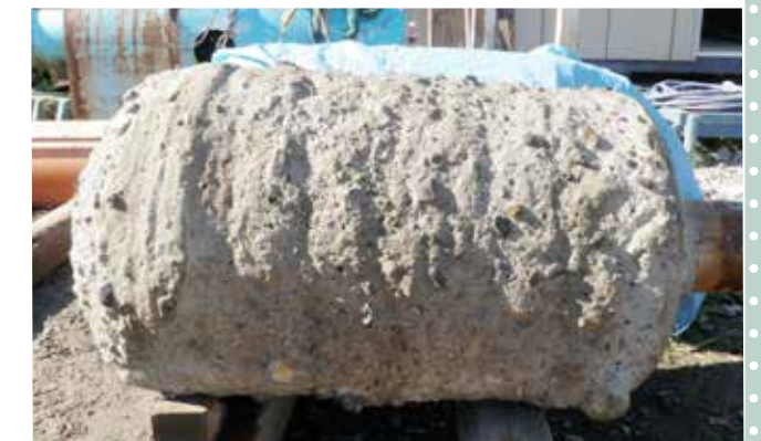
砂礫地盤から掘り出した根固め
